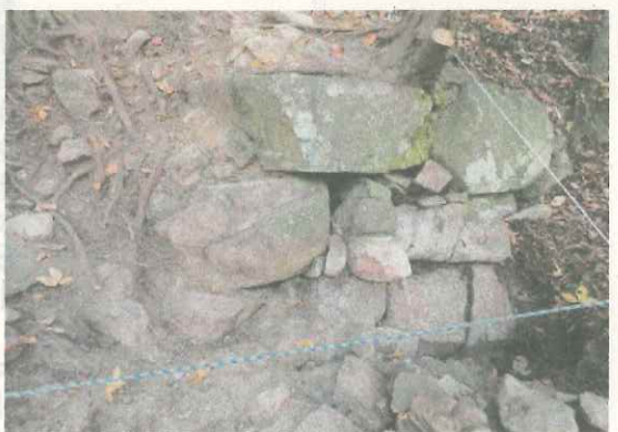
天主台石垣北東隅角部（東から）
