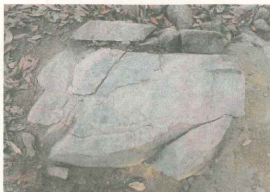
本丸取付台建物1の礎石焼損状況（西から）
